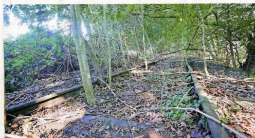
Die Natur beansprucht die Schienentrasse der alten Jülicher Kreisbahn, hier bei Kirchberg.
