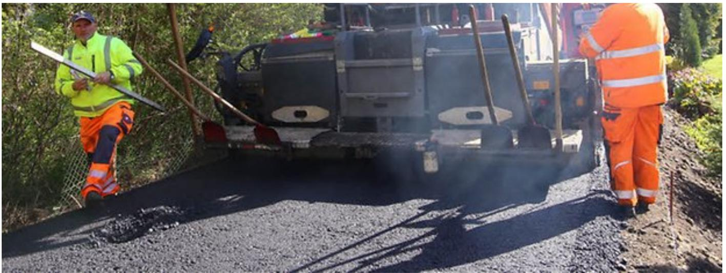
In drei Schichten wurde der Asphalt aufgetragen, um die Belastungen auffangen zu können. Schutzwände werden noch installiert.
